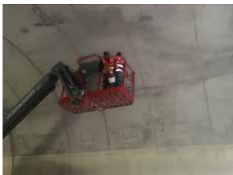
Rissverbesserung an der Tunnelinnenschale
