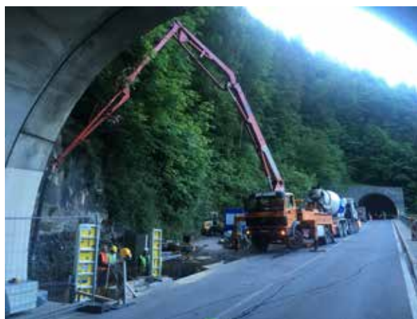
Neubau Betriebsstation am Ostportal Suldistunnel
